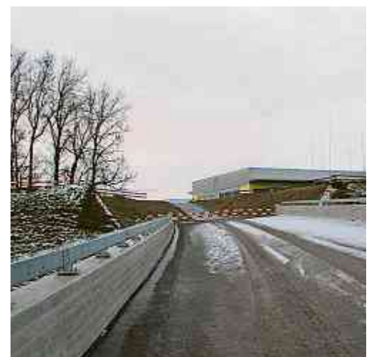
Der Bau der Umfahrung Bütschwil gewährleistet die zügige Anbindung an den Verkehr.
